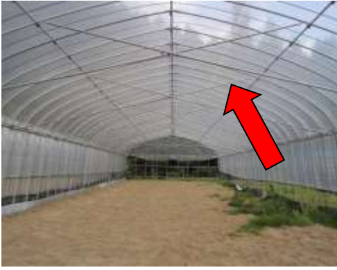
クロスバーによる補強
